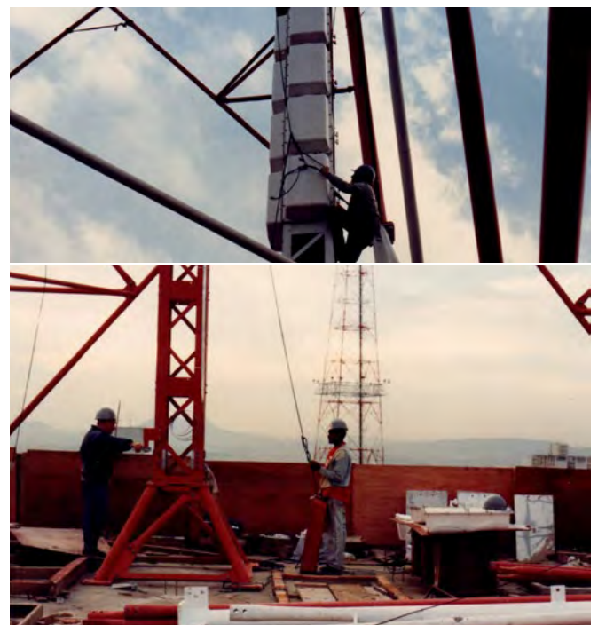
No prédio da TV, pessoal coloca alguns elementos do que seria a nova antena da MTV no polo 113 e 114/ Fotos: Arquivo Pessoal
