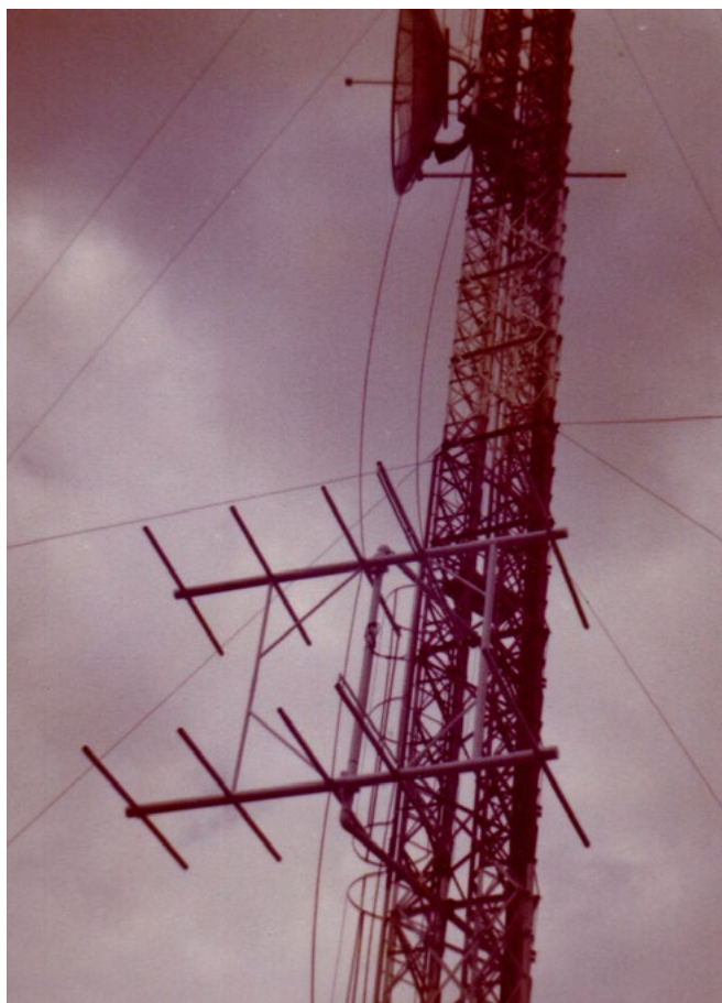
RPTV de Orlandia no CH 20. Detalhe de arranjo de Yagis de recepção do ARCH 3 de Ribeirão Preto com Link STD BY/ Fotos: Arquivo Pessoal
