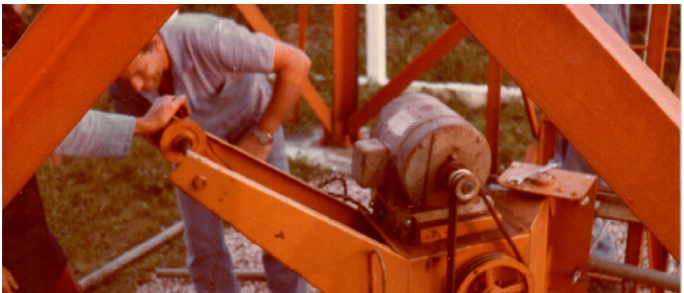
Último check no guincho para içar parabólica de 4,5m fabricada para a TV Cultura em Amparo (SP) em fevereiro de 1980 / Foto: Arquivo Pessoal
