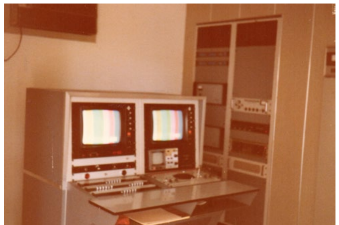
RTV São José do Rio Preto. Abrigo típico padronizado da fase que a TV Cultura construía os seus próprios prédios. No interior, Console de monitoração e comutação padronizada/ Foto: Arquivo Pessoal
