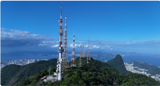
Antena de transmissão DTV+ no Morro do Sumaré no Rio de Janeiro/ Foto: Globo
