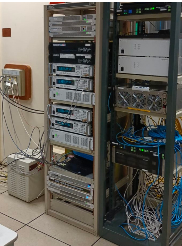
Figura 5 - Equipamentos de transmissão conectados à gaiola de Faraday/Foto: Ricardo Rabaça.
