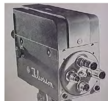
Câmera RCA TK-30 usada na TV Tupi, em 1950 / Foto: Reprodução
