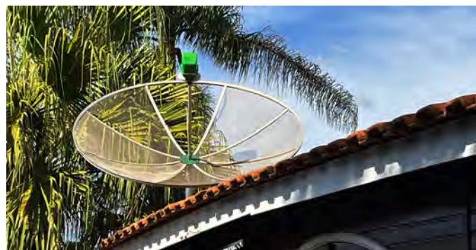
Parabólica analógica com recepção de Banda C instalada em residência do interior de São Paulo / Foto: Fernando Moura
